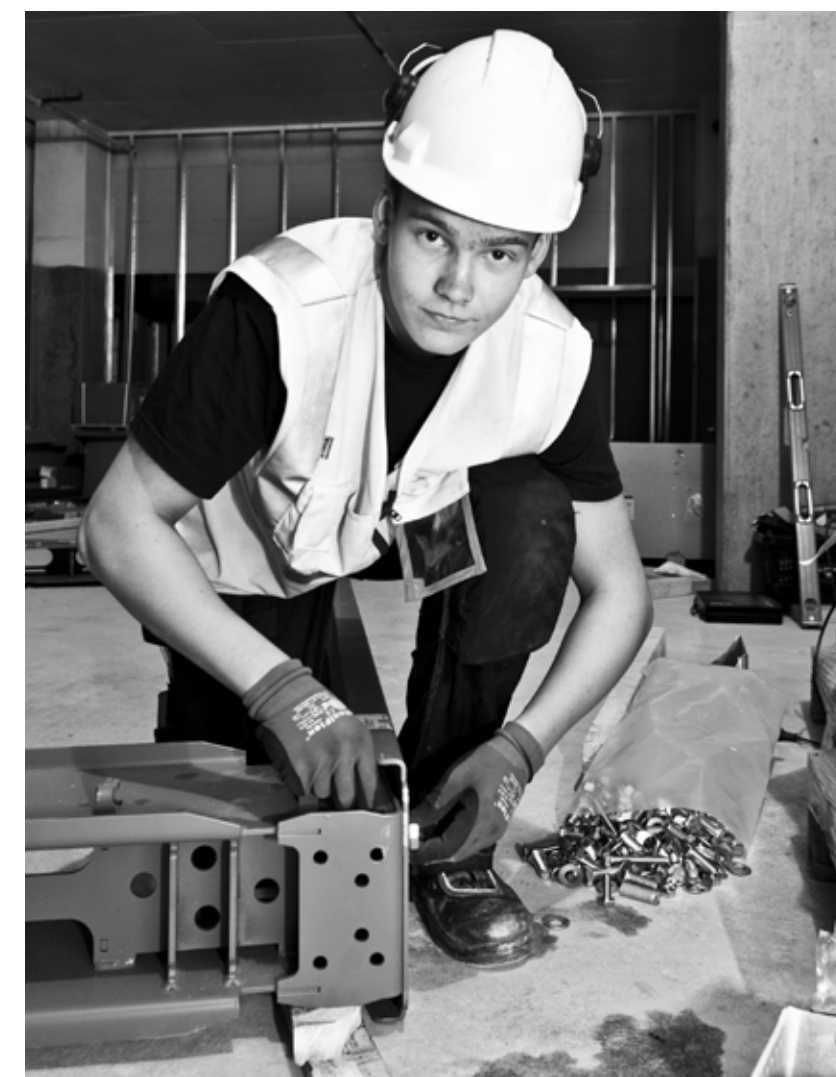
Lærling Nicklas Olsen Briem er igang med å montere sammen motvektsramma 4,2 tonns heis.
