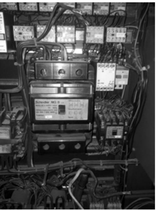
Rivningsfirmaet hadde kappet tilførselen til heisen uten å sjekke om strømmen var slått av. Kontaktor brant inne.
