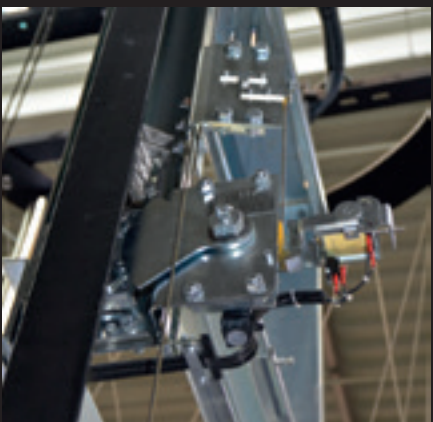
Hastighetsregulator og fangapparat fra Vertima.
