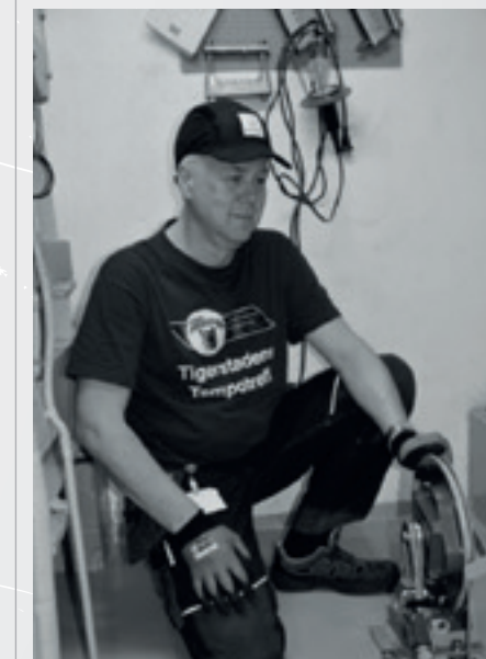
Hastighetsregulator sjekkes visuelt
