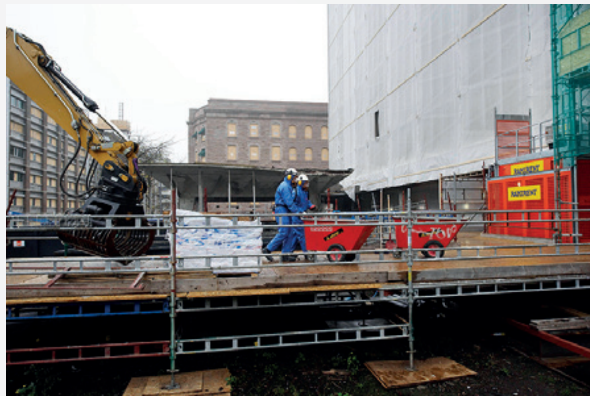
Innleide på regjeringsbygget
