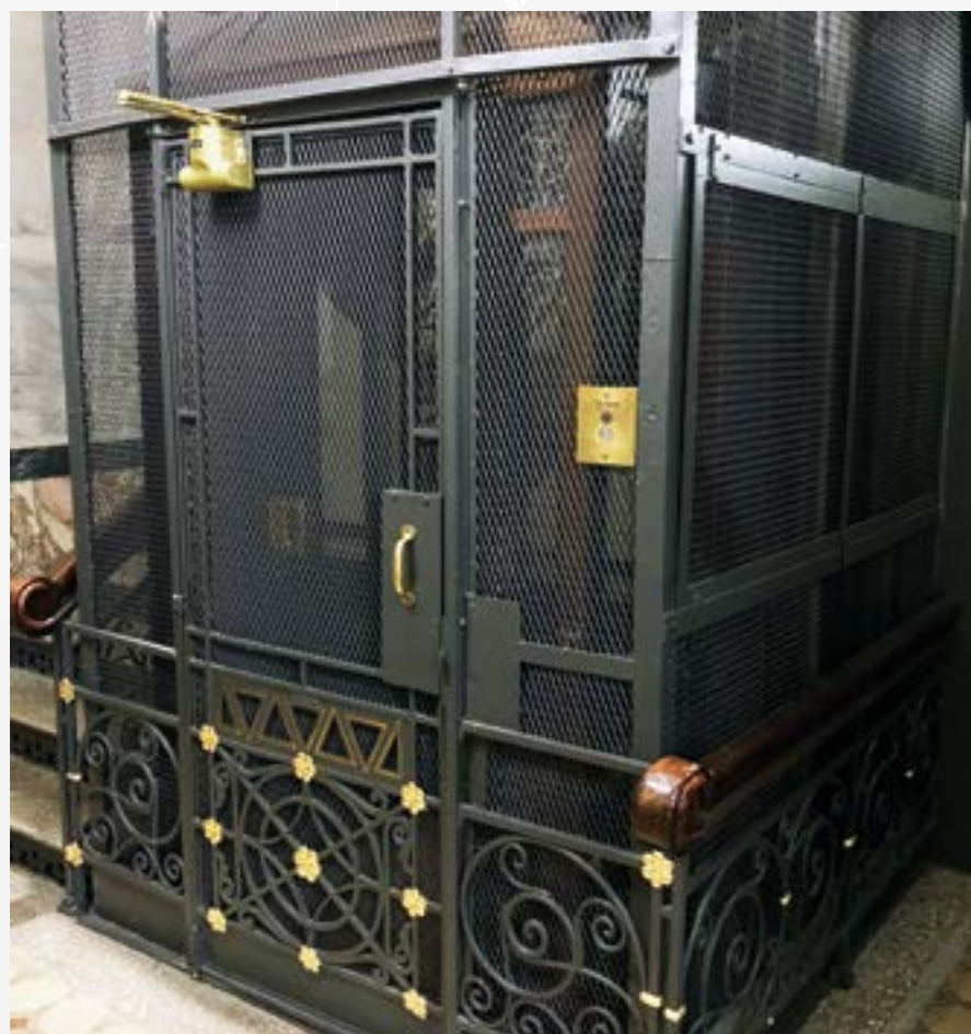
Dette er i følge NHK og OHK den eldste heisen i Norge som fortsatt er i drift. Den befinner seg på Stortorvet 5 i Oslo og er bygd i 1898. Det finnes noen andre heiser i for eksempel Slottstallen uten klar identifikasjon av alder opplyses det.
