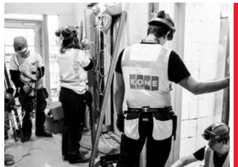
Samarbeid ved hesimontasje Aker brygge
