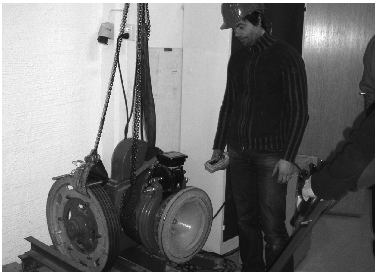
Heising av maskin etter forskriftsmessig anhuking.
