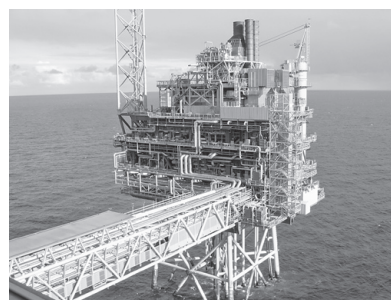
Oseberg feltsenter består av tre plattformer som er forbundet med gangbru. Her er det Hydro som er operatør. På Oseberg A er det fire wireheiser og fire Alimaker, en i hver skift. På Oseberg B og Oseberg D (bildet) finnes det en wireheis på hver av plattformene
