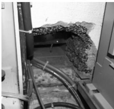
En betongutsparring for kabler ved siden av maskin viser at sjakten er av Leca.
