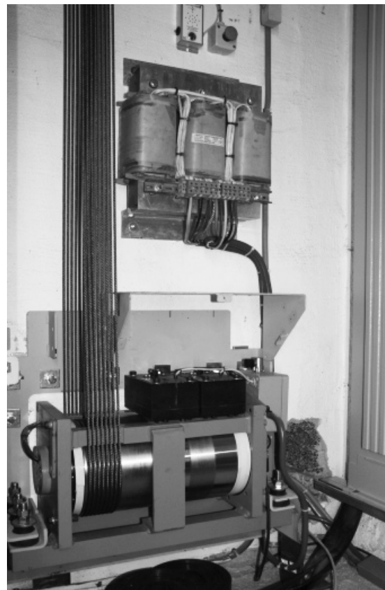
Maskin plassert i sjaktbunn med innfestning i vegg. Sjaktgruben er 26cm dyp.
