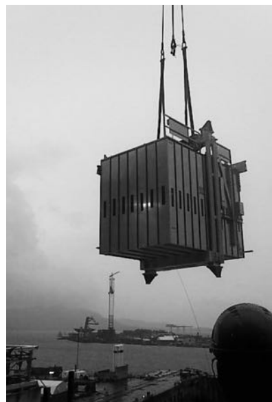
Her heiser vi inn stolen fra toppen av sjakta, før maskinrom og øverste etg er satt på plass.
