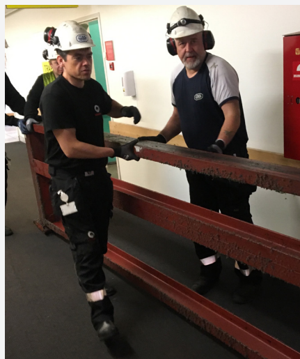
Heisdemontering innebærer tunge løft. Men det er også moro.
