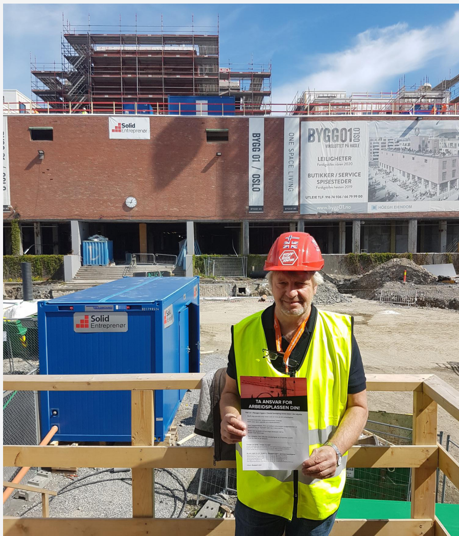
En av oppgavene til Byggpatruljen er å spre informasjon på byggeplassen.
