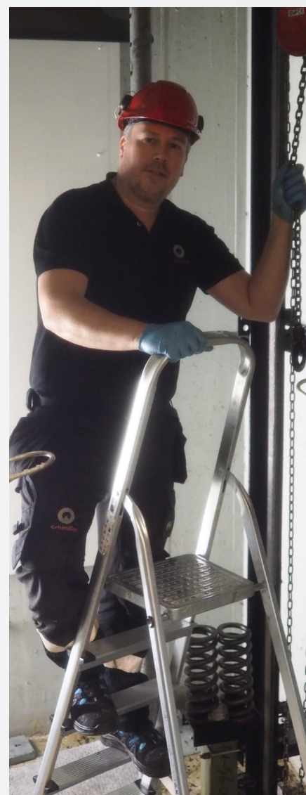
Tommy Torp gjør effektivt ferdig et pakningskift på et stempel ved en Hydroelite på Sortland.
