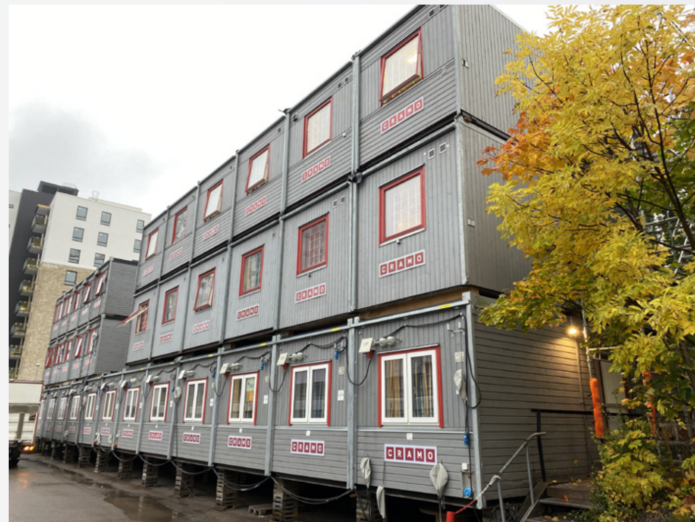
Vi må selv se til at kravene til brakkeforhold blir opprettholdt. Benytt deg av ditt verneombud hvis dårlige brakkeforhold ikke blir utbedret.
