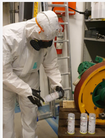
Kjelleren og labben på HBU pusses opp. Her er det en maskin som får et strøk med lakk.
