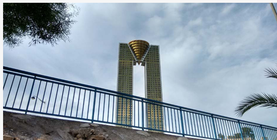
Utbygger skal ha glemt å tenke på heissjaktene da byggeplanene ble endret. Foto: Ruben Martinez Vilar, Flickr.
