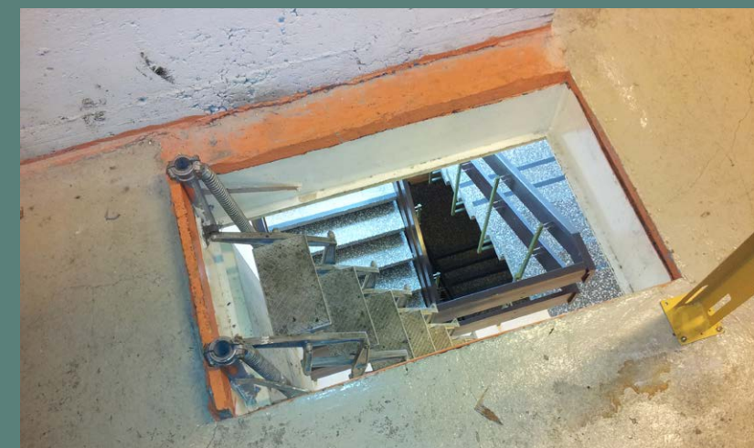
En loftsluke som adgang til maskinrommet er allikevel blant de enkle adkomstene!
