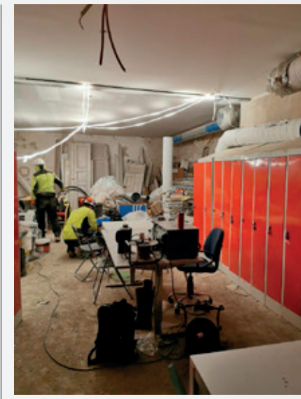
Skifte og spiserommet i kjelleren.
