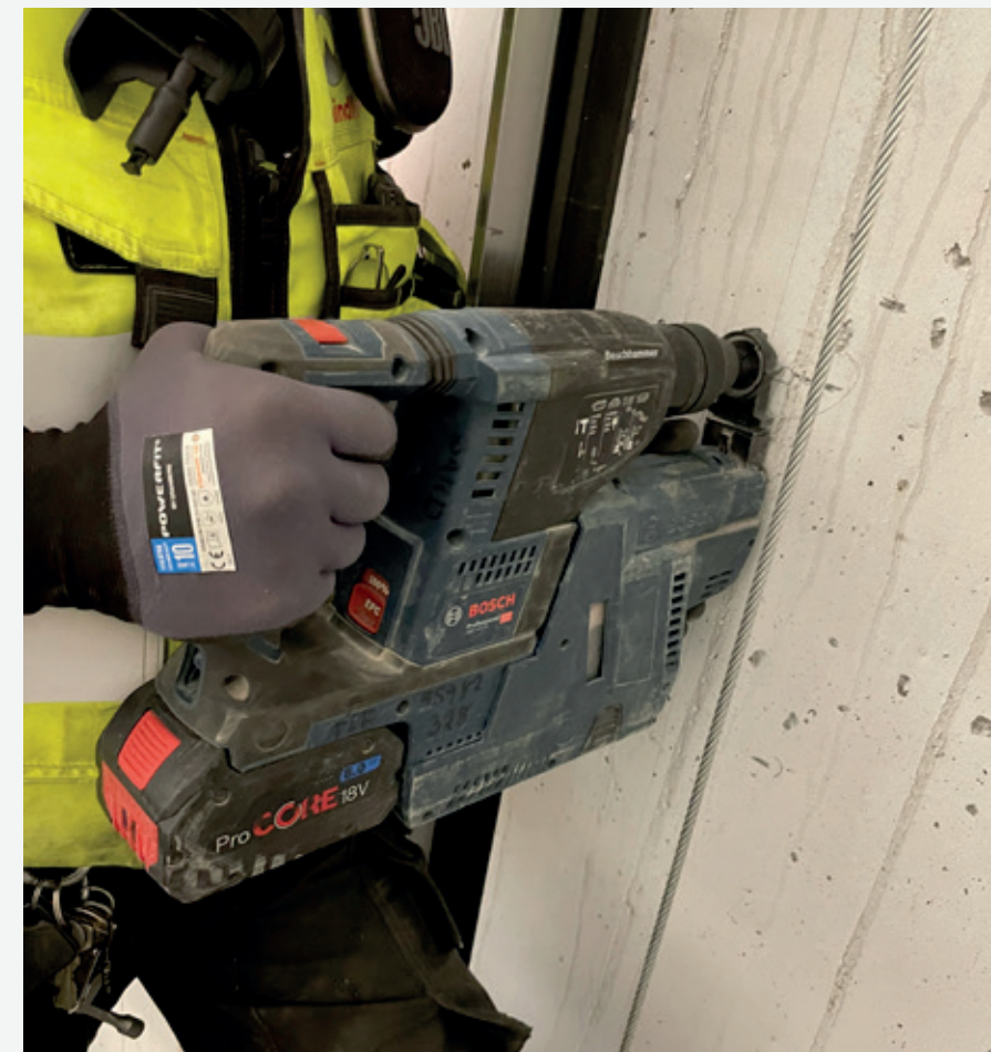
Både Kone og Schindler har gjennomført støvmålinger. Foto: Teodor Kirkenær.
