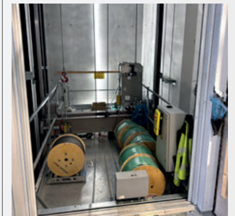
Montørene fra Kone er snart ferdig med montasjen.
