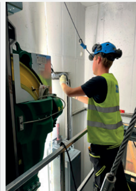
Trym Markveien Gossmann i gang med det elektriske.
